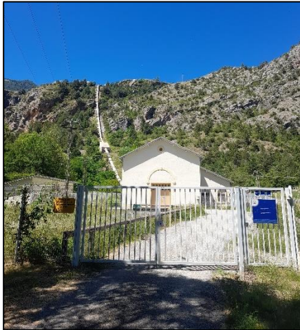
Photographie 19 : Centrale hydroélectrique de CHAMPCELLA (GEOENVIRONNEMENT, juin 2022)
