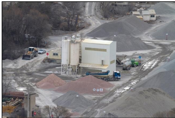
Photographie 21 : Plateforme du Planet (AGREGATS BRIANÇONNAIS)
